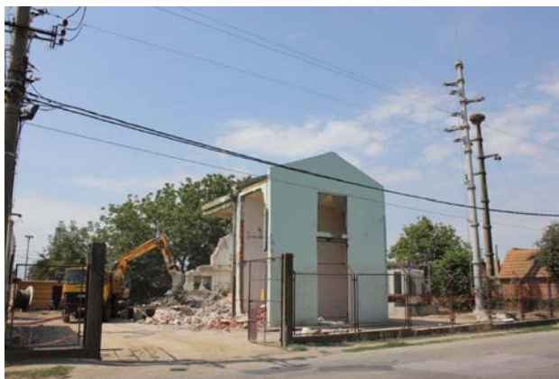
Slika 8. – Rušenje postojećeg objekta
