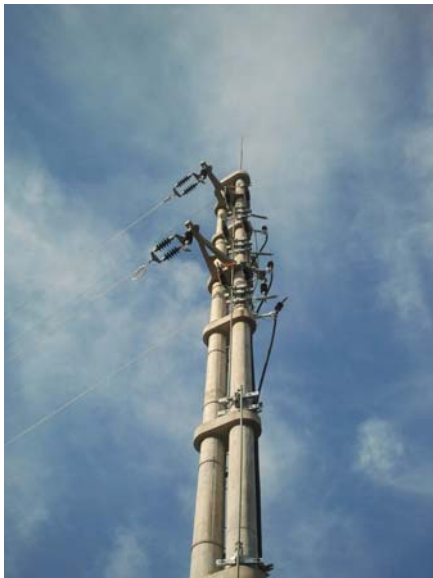
Slika 4. – Postojeći stubovi (armirano-betonski, levo, i rešetkasti od čelika, desno) koje je trebalo demontirati i zameniti novim stubovima u krugu transformatorske stanice
