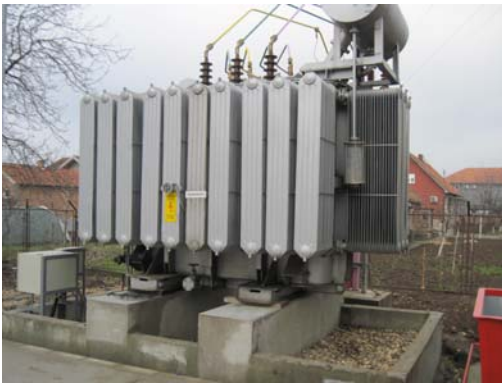
Slika 3. – Izmešteni energetski transformator i njegovi priključci
