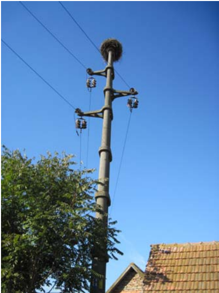
Slika 4. – Postojeći stubovi (armirano-betonski, levo, i rešetkasti od čelika, desno) koje je trebalo demontirati i zameniti novim stubovima u krugu transformatorske stanice
