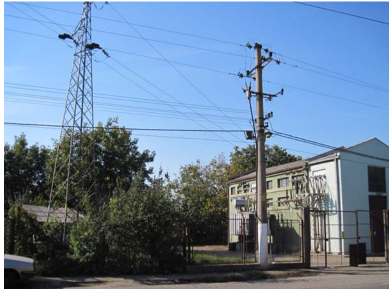
Slika 4. – Postojeći stubovi (armirano-betonski, levo, i rešetkasti od čelika, desno) koje je trebalo demontirati i zameniti novim stubovima u krugu transformatorske stanice
