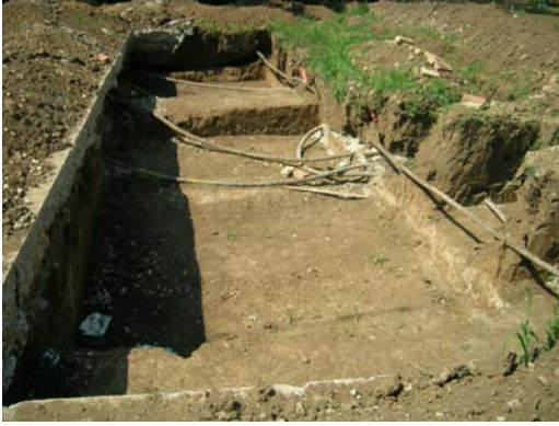
Slika 6. – Pripremni radovi za uklapanje mobilnog postrojenja
